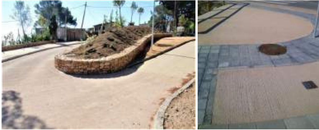
Foto 28. Integració i aspecte més natural del formigó amb l'aplicació de sulfat de ferro diluït
