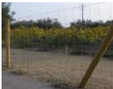
Foto 30. Tanca perimetral de tipus cinegètic amb suports de fusta i passos per microfauna
