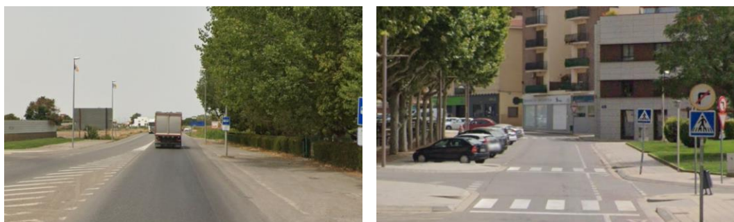
Figura 4.26.— Ronda Ponent (esquerra) i avinguda del Canal (dreta)
